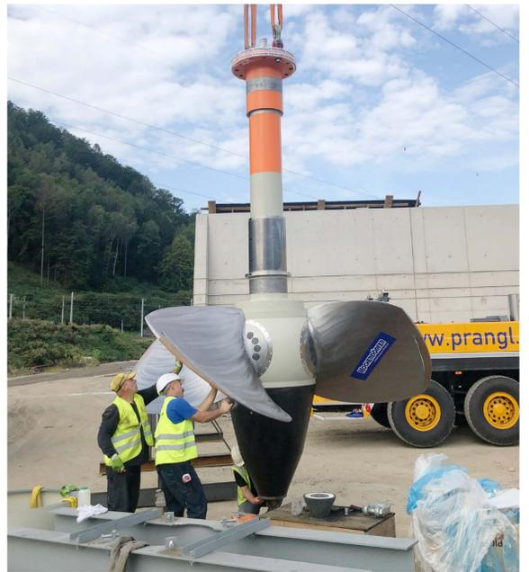
Turbinennennleistung: 5,8 MW
